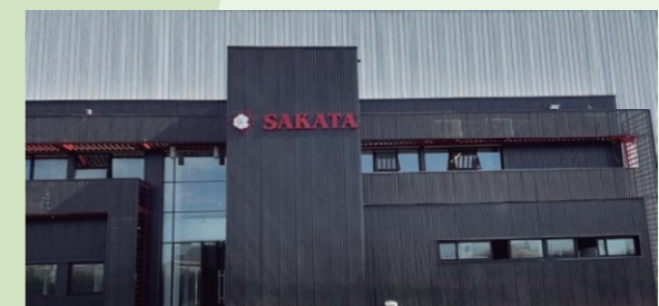
2022年に新設したフランス(上)とチリ(下)の大型倉庫
